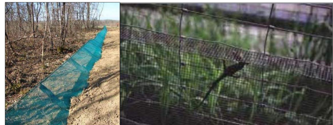
**Exemple de mesure pour éviter l'intrusion d'amphibiens sur les zones de travaux (source Biotope)**
